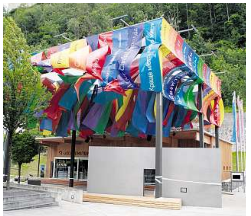
Leicht beschädigt: Durch den starken Wind haben sich beim Expo-Pavillon die Metallstangen aus dem Saum der Fahnen herausgelöst. Bild Daniel Ospelt
